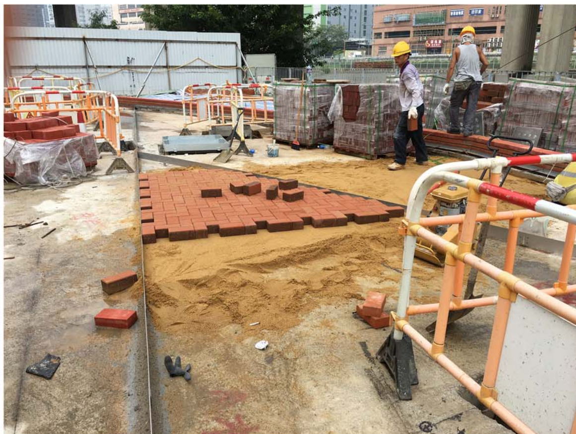
地磚鋪設工程進行中
