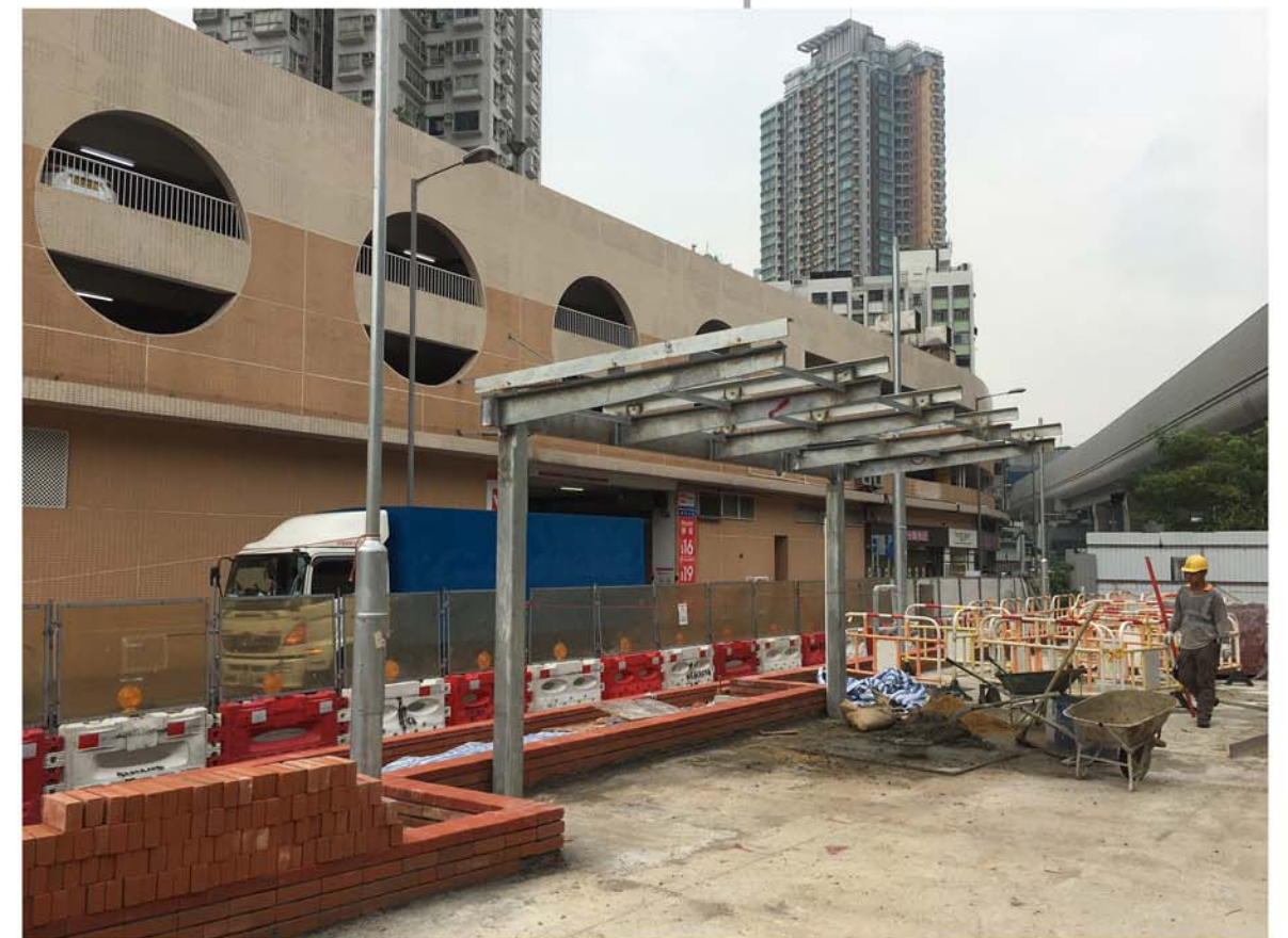
座位蓋頂工程進行中
