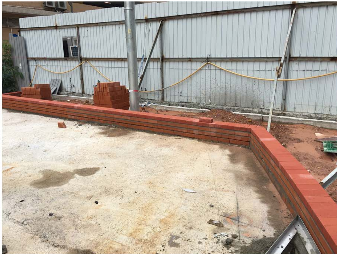
牆身磚鋪設工程進行中
