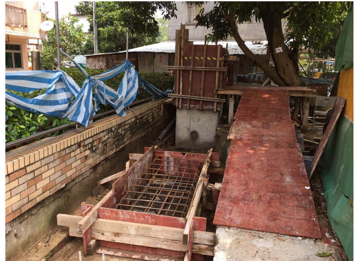
電線井及有蓋座位結構工程進行中
