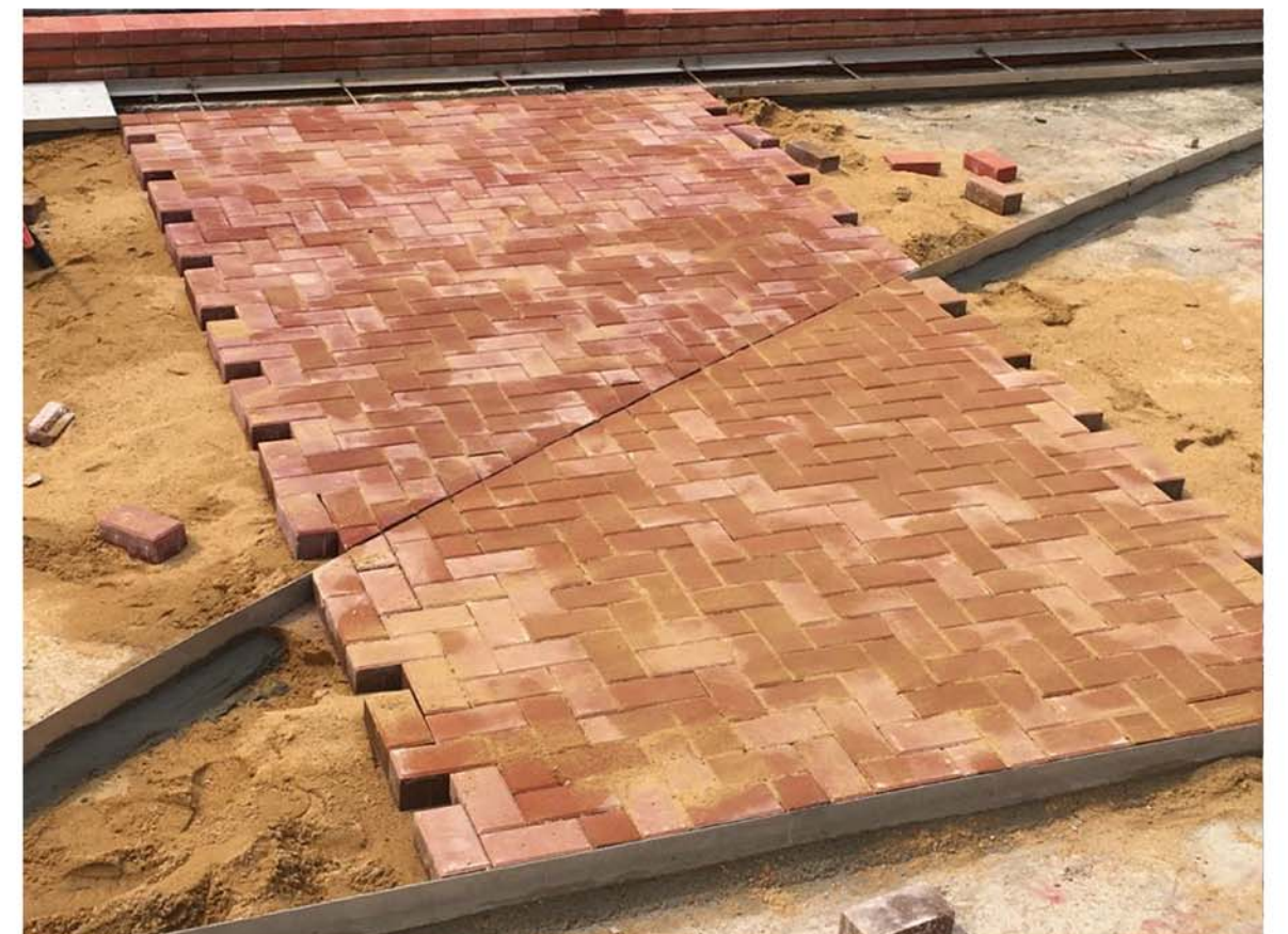
地磚鋪設工程進行中
