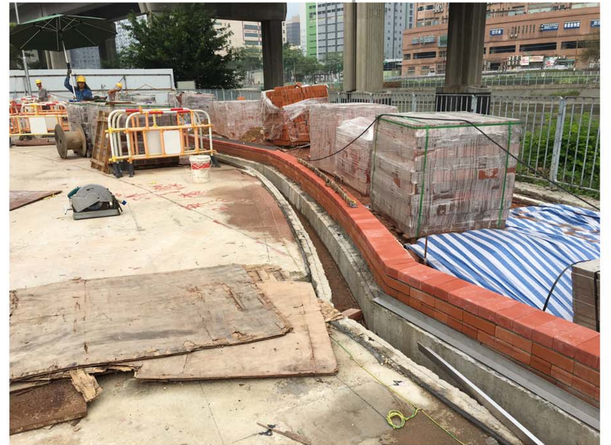
牆身及渠蓋工程進行中
