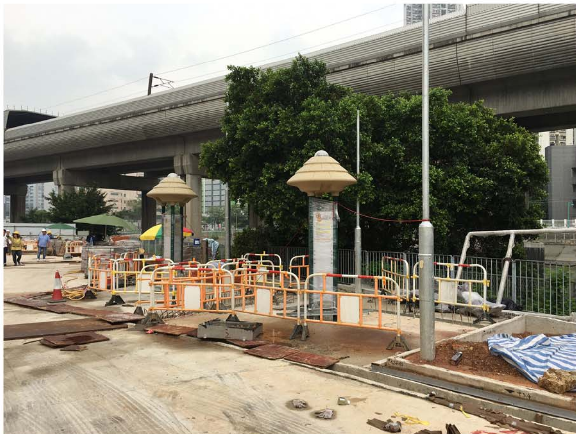
長者設施完成
