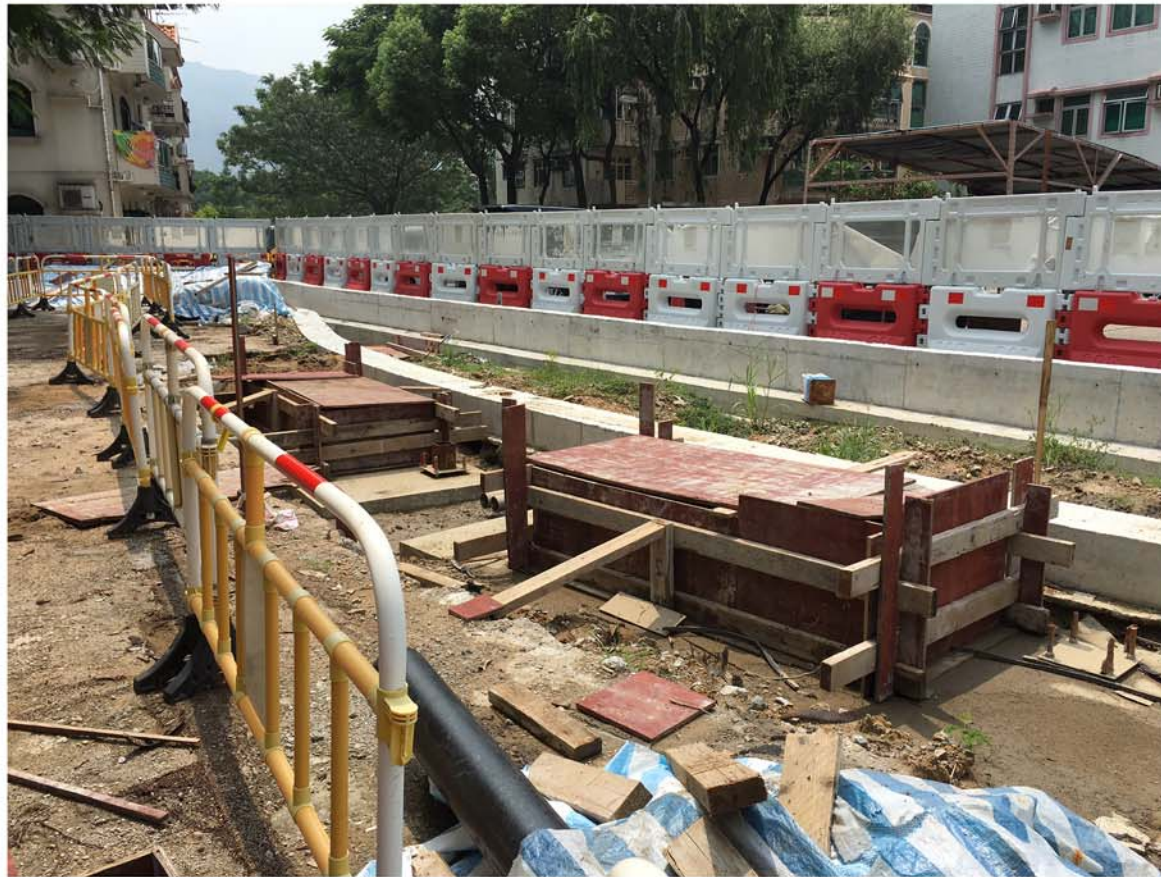
有蓋座位結構工程進行中
