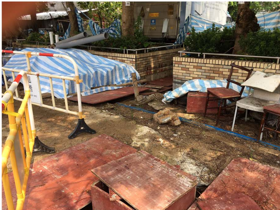
排水工程進行中
