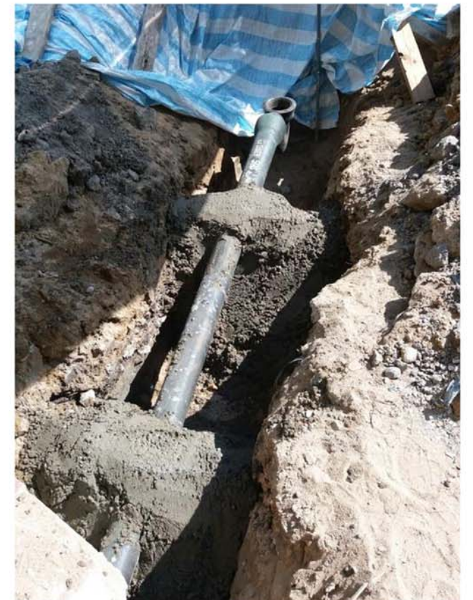
排水工程進行中
