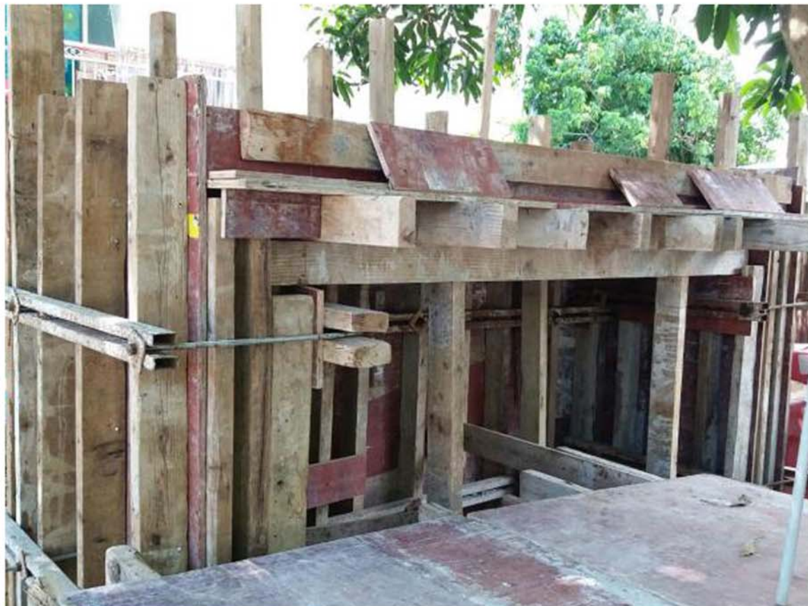
電箱工程進行中
