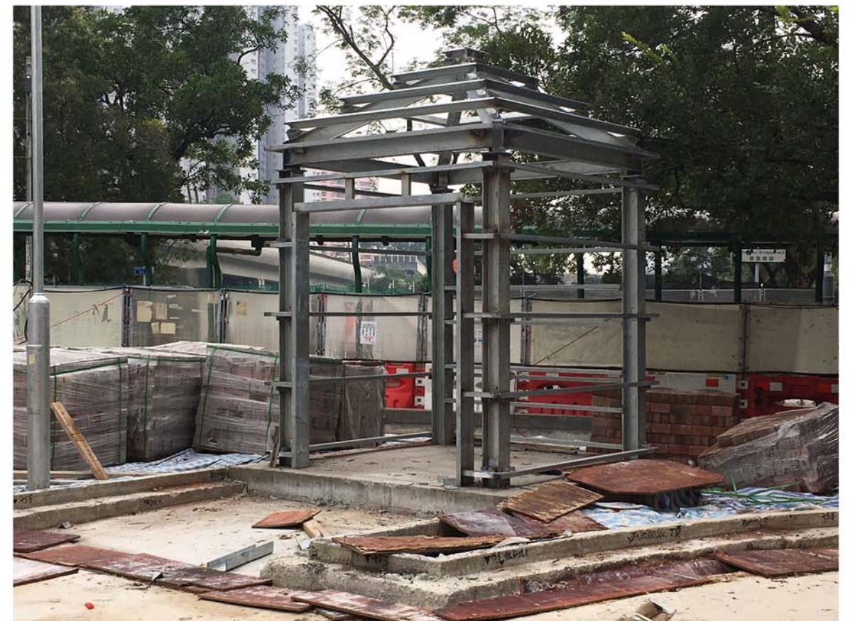
儲存間工程進行中
