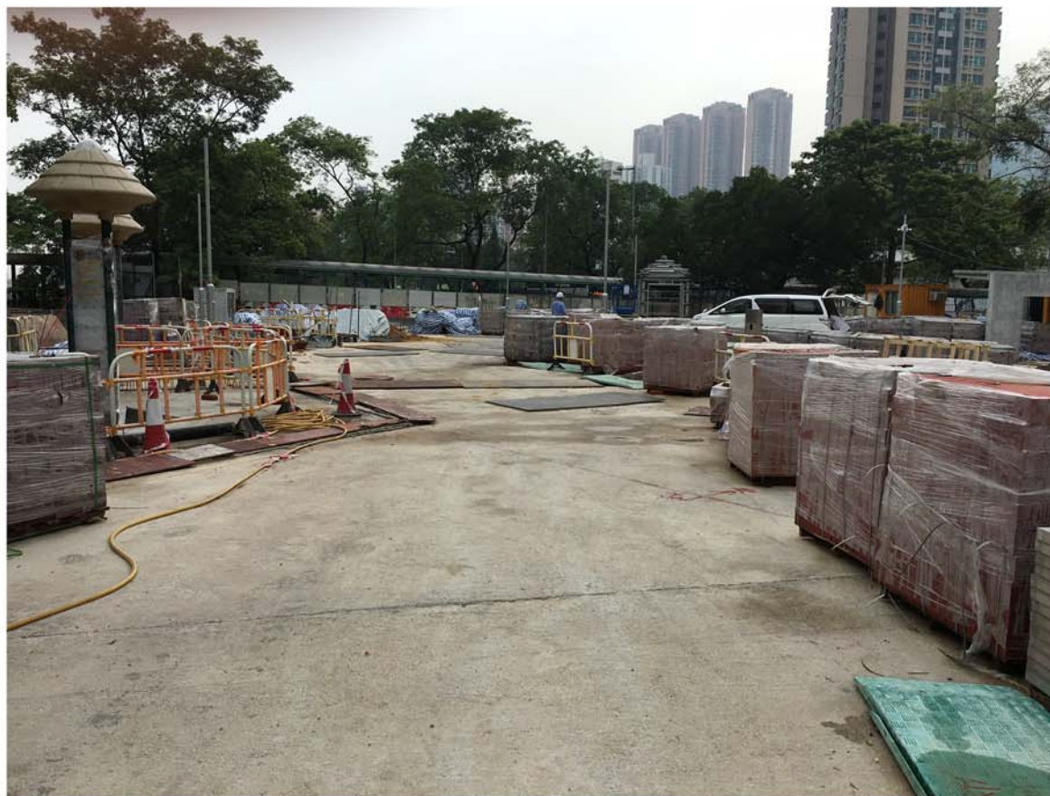
地面硬底處理完成
