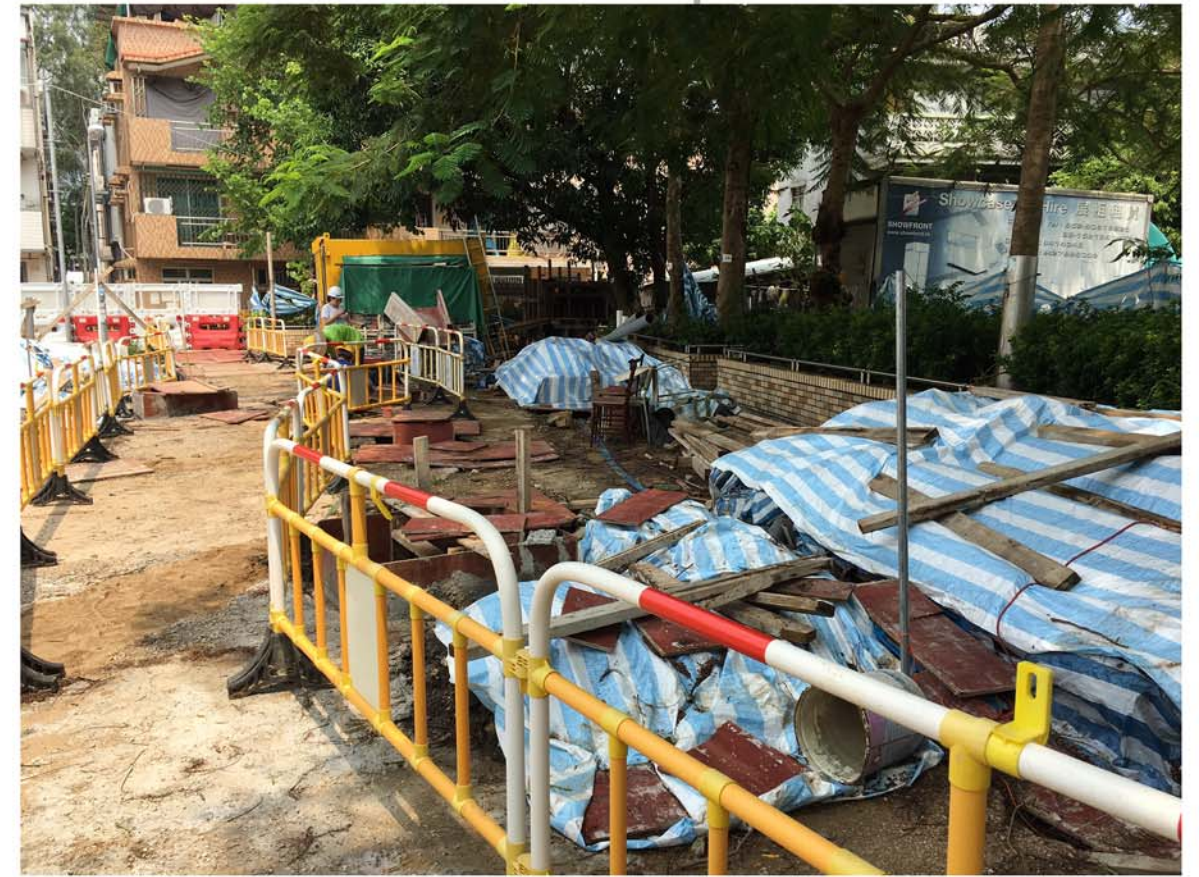
電線井工程進行中
