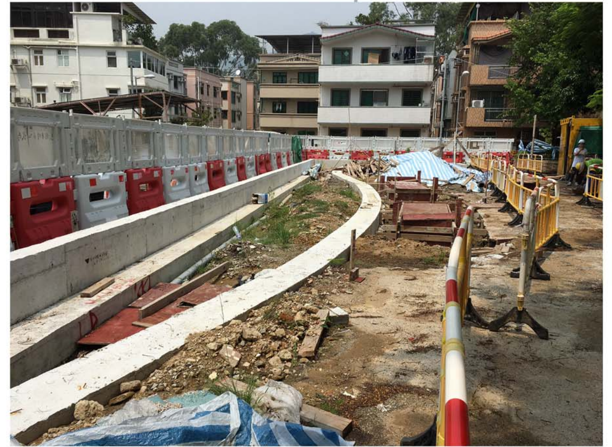
花槽結構工程完成
