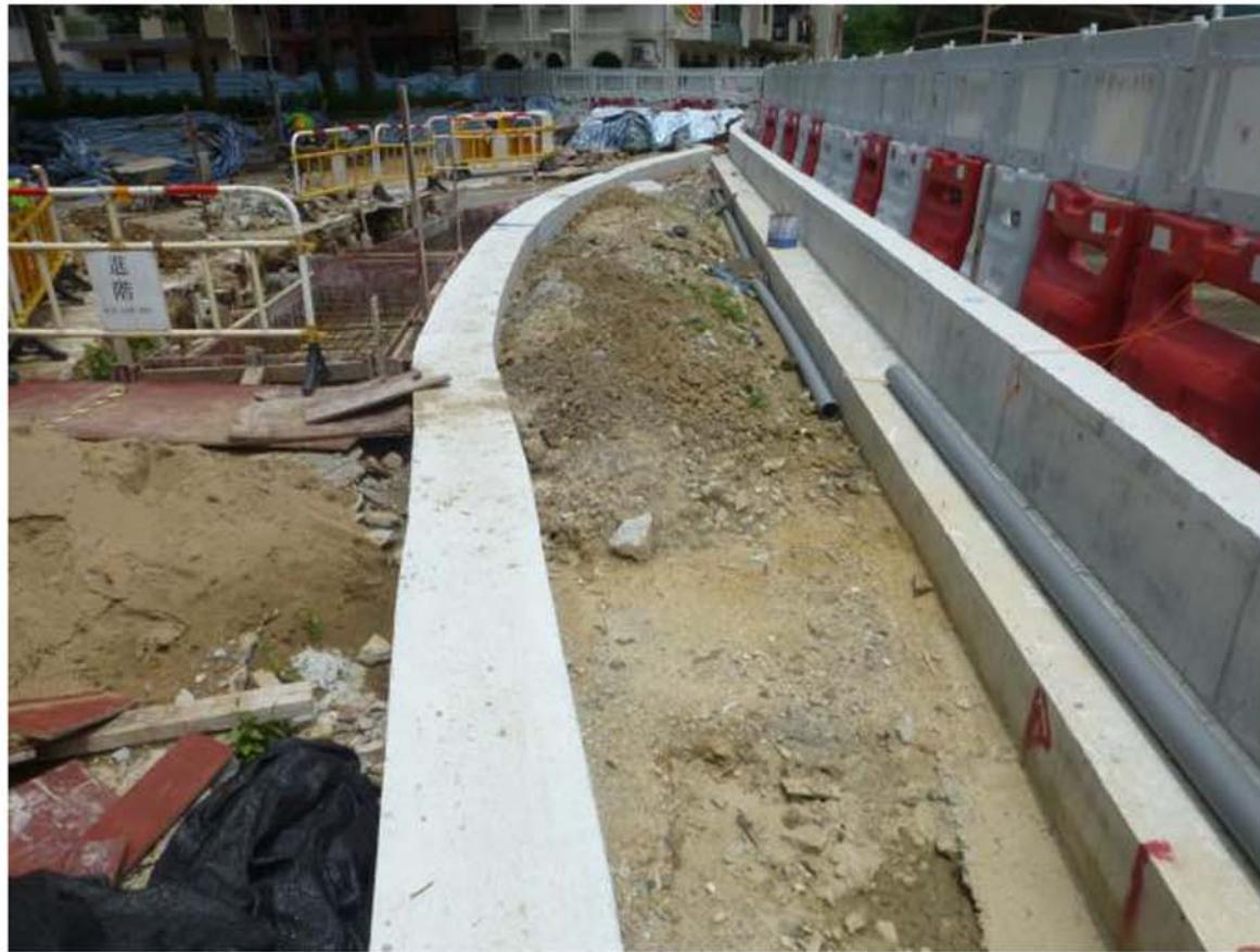
花槽結構工程完成
