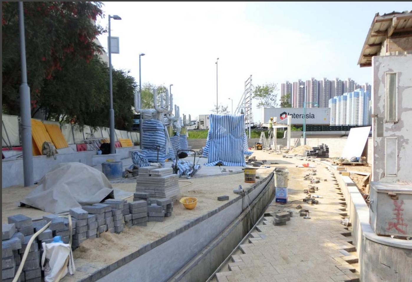
整體花槽已完成，鋪砌地面磚工序已接近完成。
