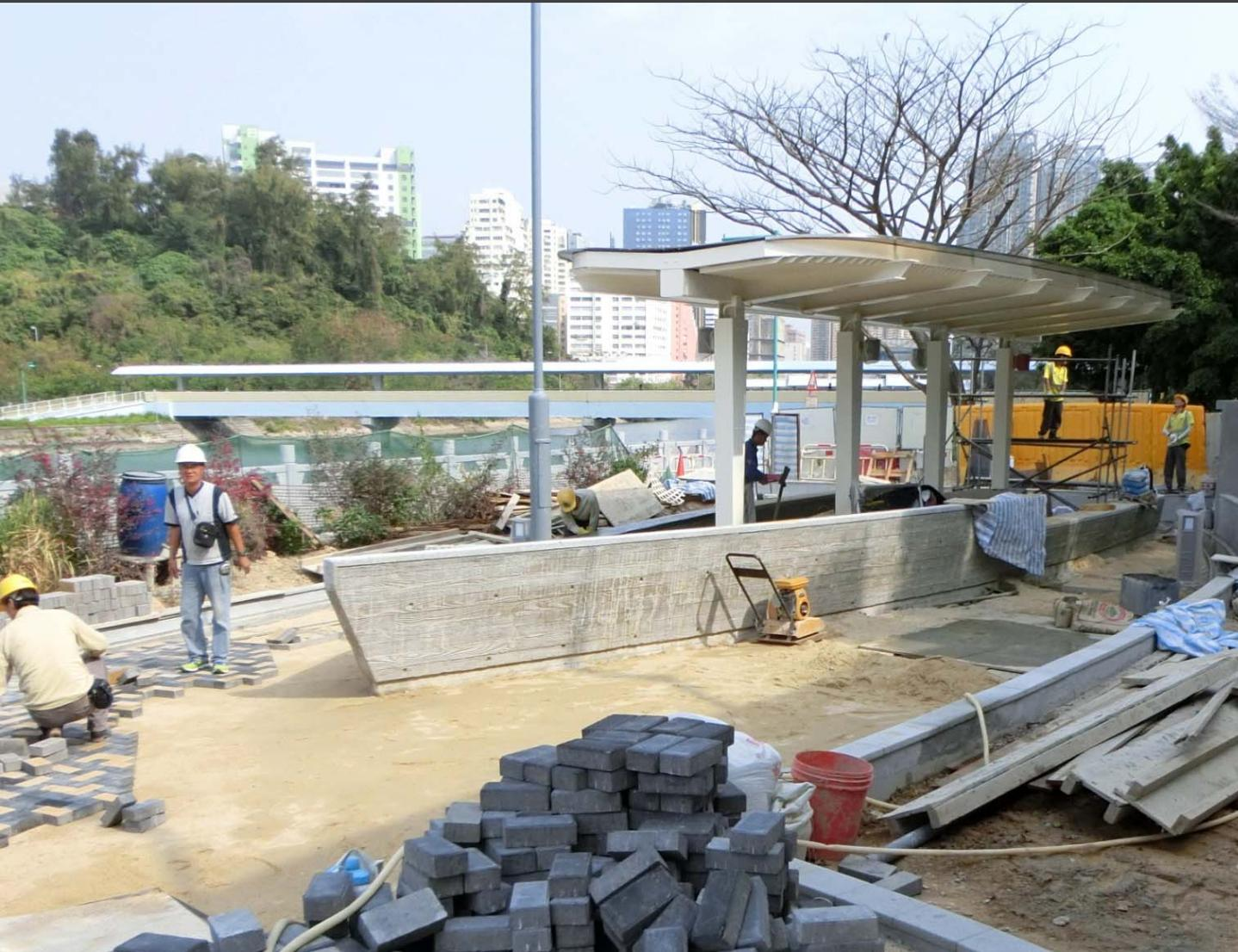
船形蔭棚已竣工，旁邊地磚鋪砌工序現正進行中。
