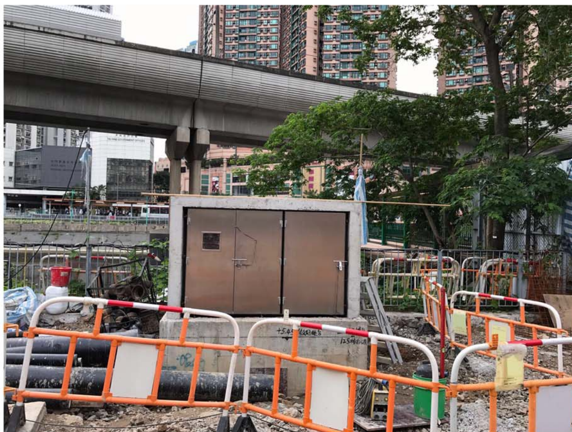
電箱工程進行中
