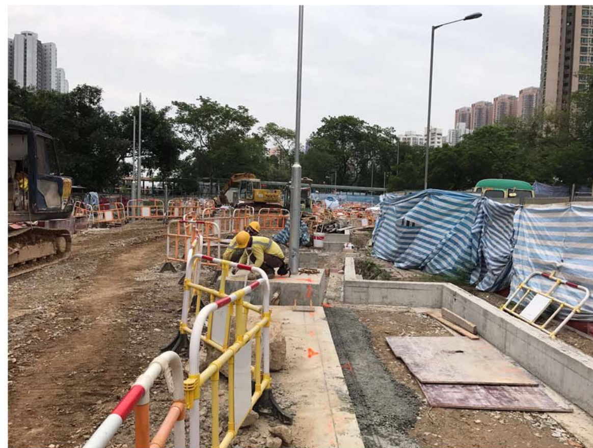
花槽及燈柱工程進行中
