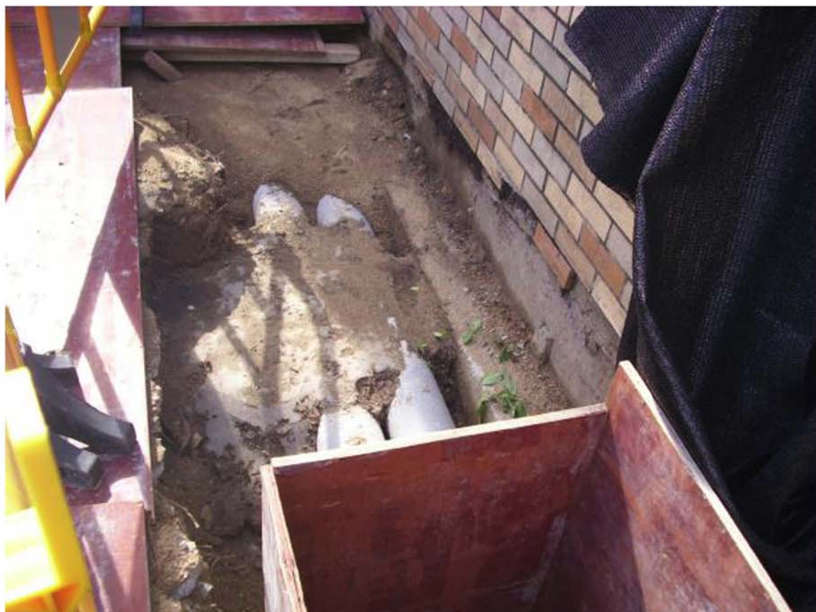
電箱及電纜管道工程進行中
