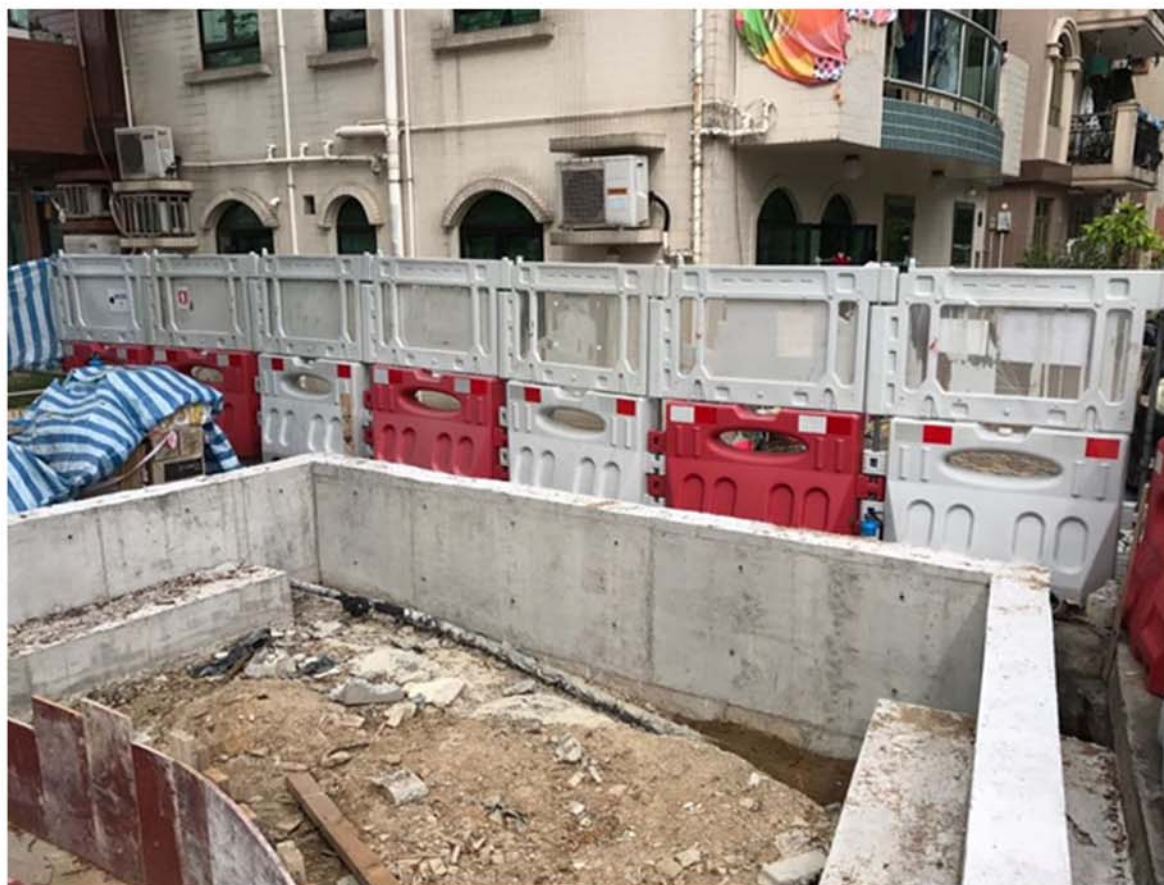
花槽結構工程進行中
