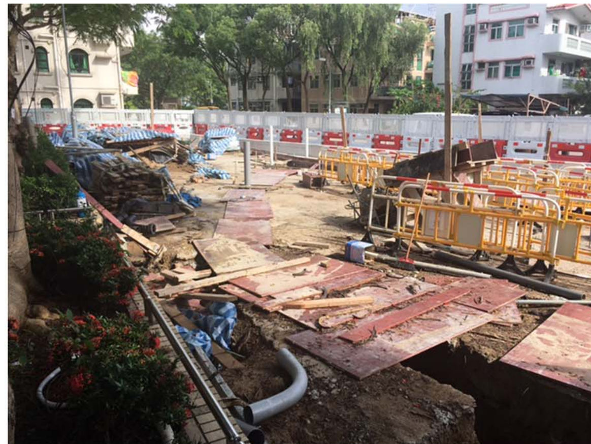
排水管道測試中
