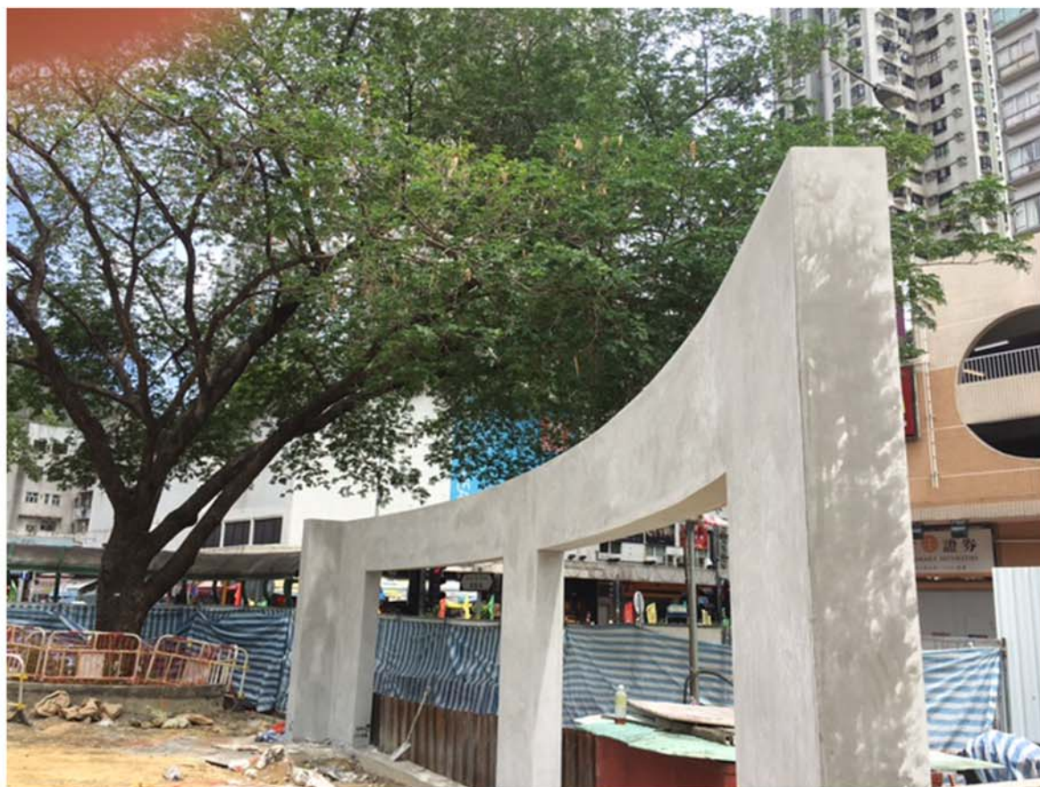
特色牆混凝土結構完成
