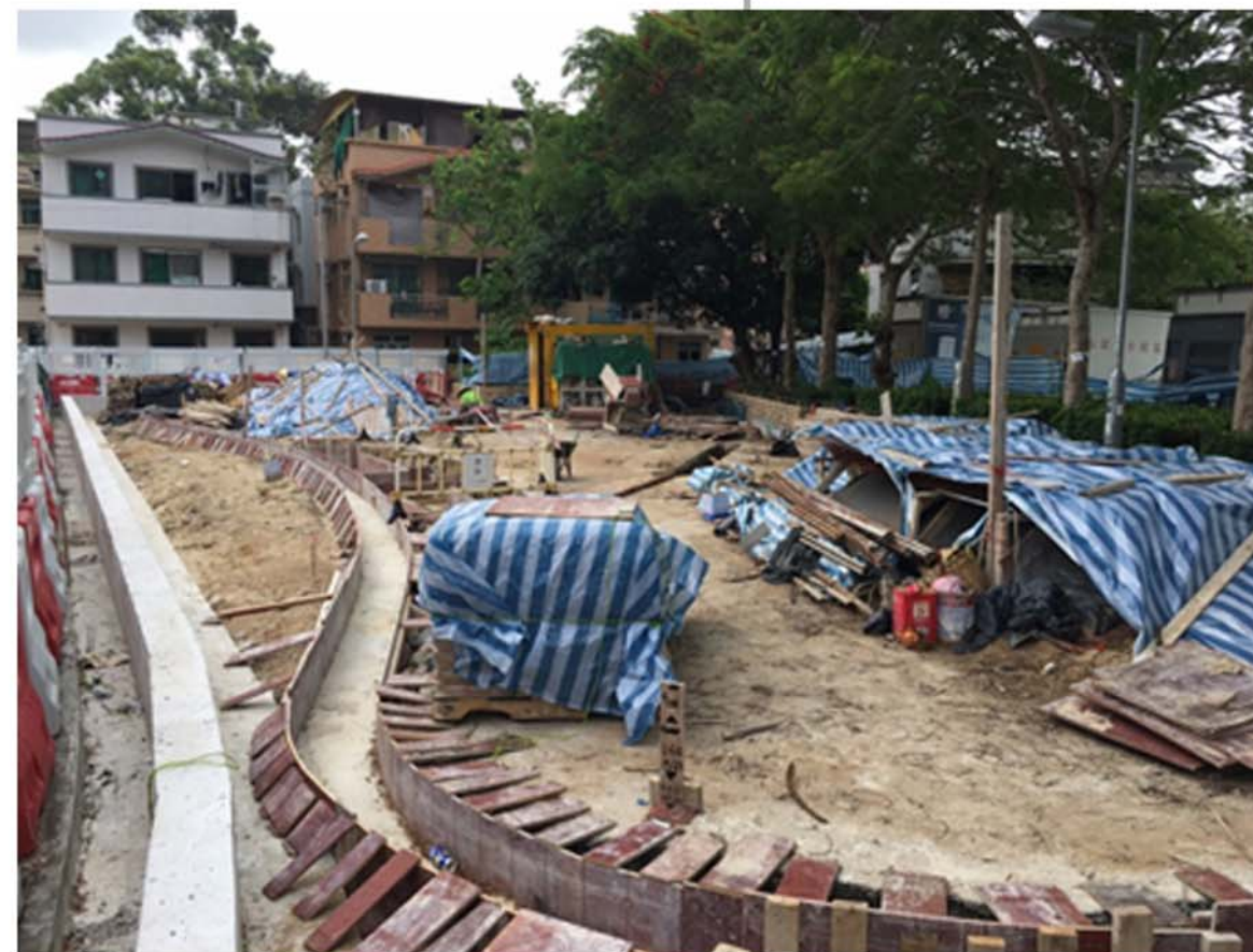
花槽結構工程進行中
