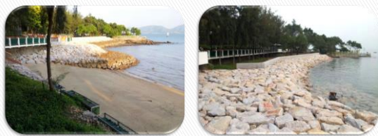
蝴蝶灣泳灘海岸復修工程
