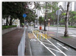
加設行人過路設施 (鳴琴路)
