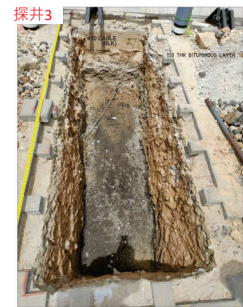
探井3: 探井尺寸為 1米 (闊) x 3米 (長) x 1.2米 (深)
