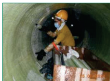
無坑修復水管
