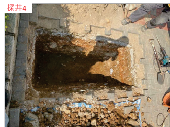
探井4: 探井尺寸為 1米 (闊) x 2米 (長) x 1.2米 (深)
