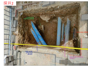
探井2: 探井尺寸為 1米 (闊) x 1.6米 (長) x 1.2米 (深)
