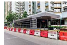
建造車站及出入口結構*
