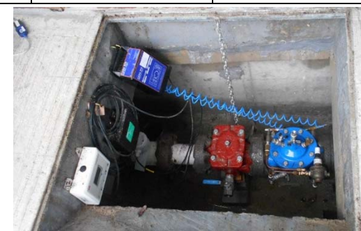
流量計、減壓閥及其他有關設備的安裝
