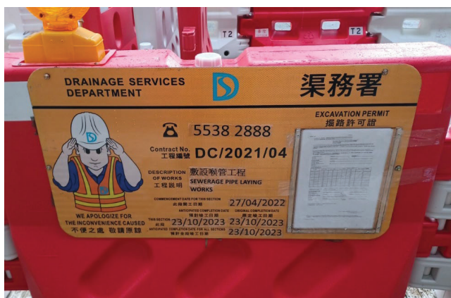
在工地標示熱線電話號碼
