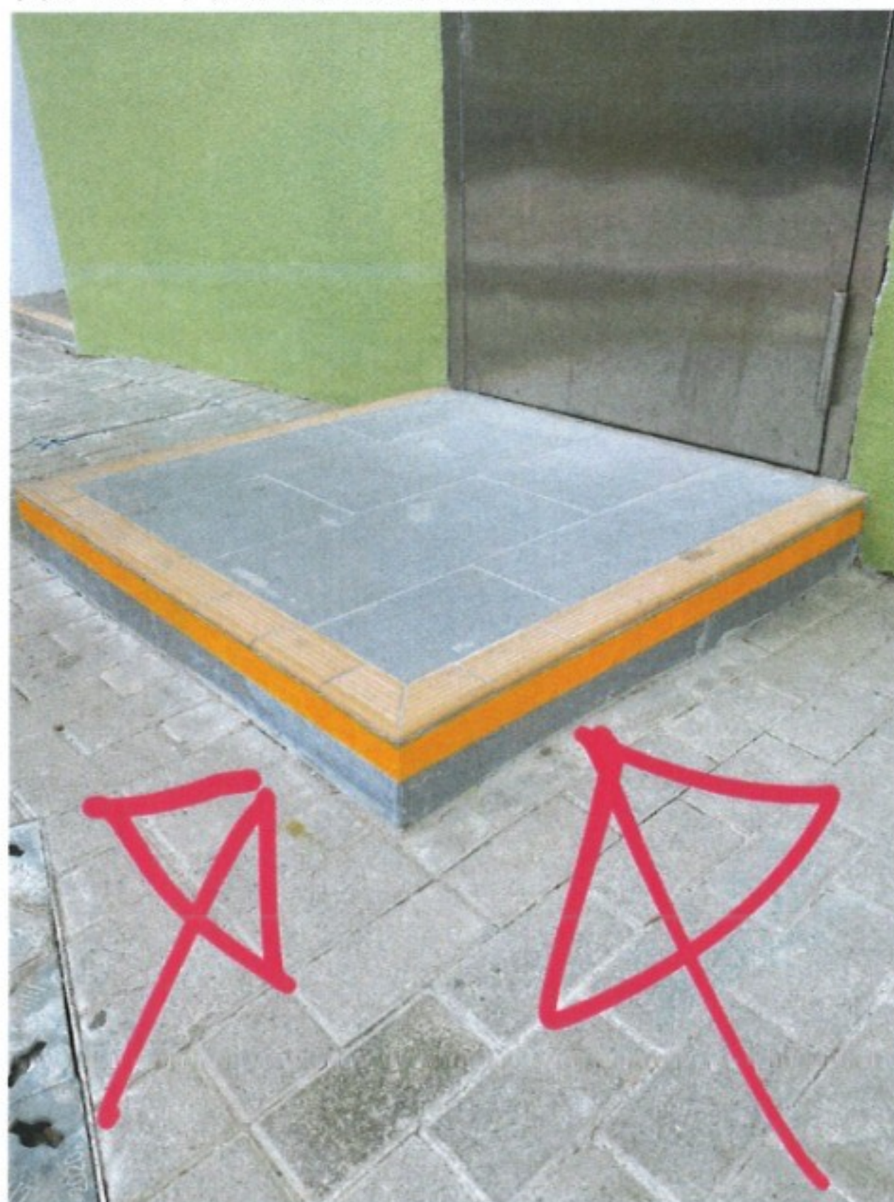
水泵房外凸起之平台
