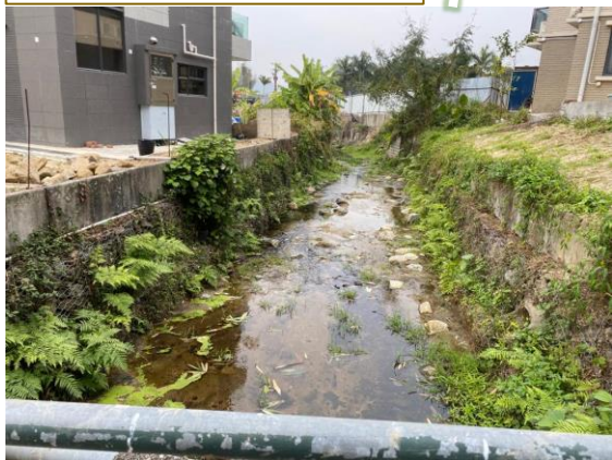
擴建部分現有河道
