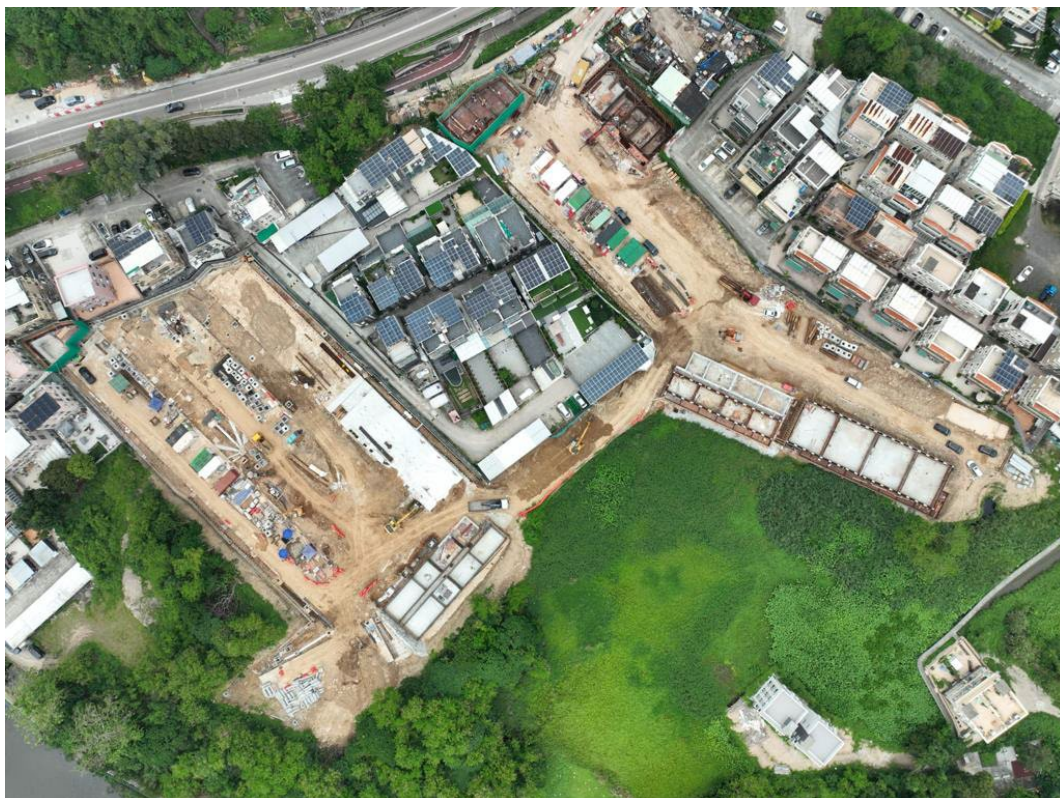
工地施工情況（一）
