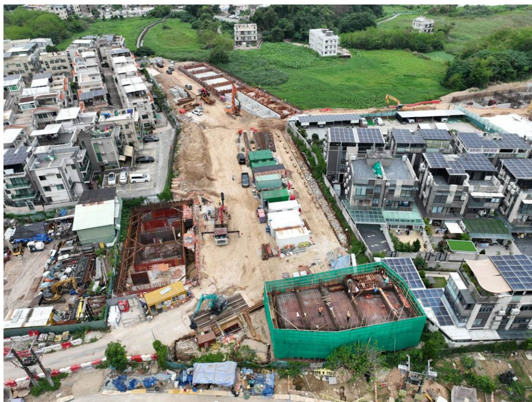
工地施工情況（二）
