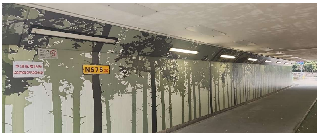
8. NS75 行人隧道一牆壁貼圖一
