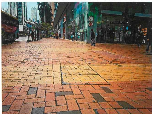
附照三：荃新天地二期對出的楊屋道行人路
