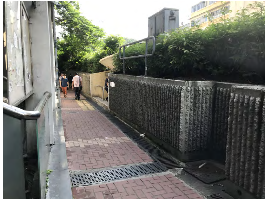
結構編號: NS9 近荃灣花園的出口
