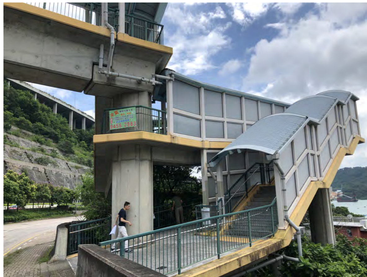
結構編號:NF390 南面出入口
