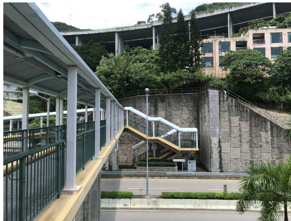
結構編號:NF390 北面樓梯出入口
