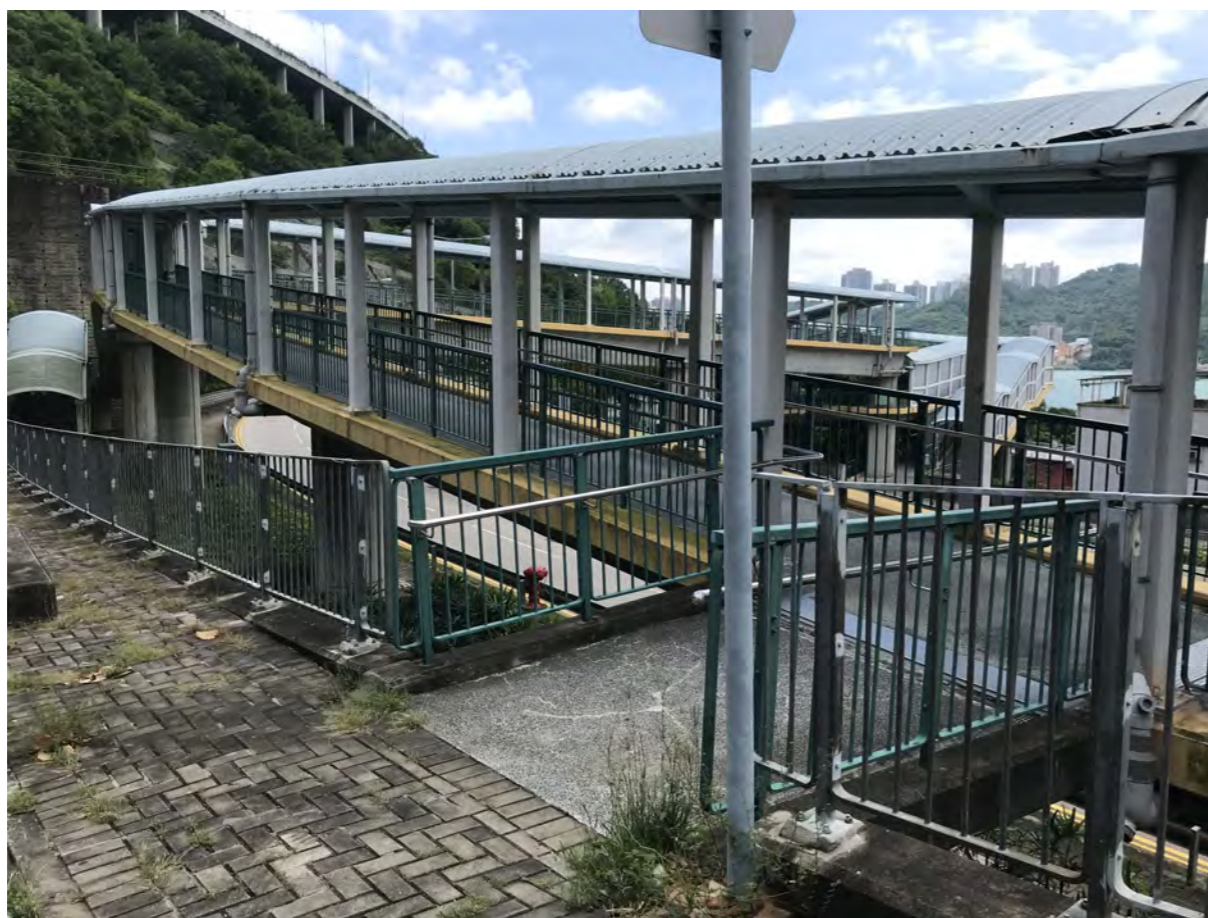
結構編號:NF390 近家和園出入口
