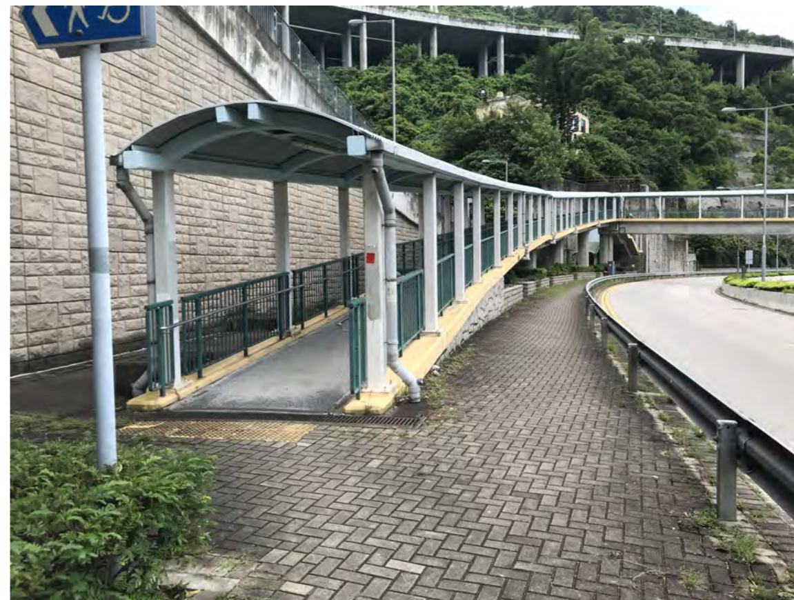
結構編號:NF390 北面斜路出入口
