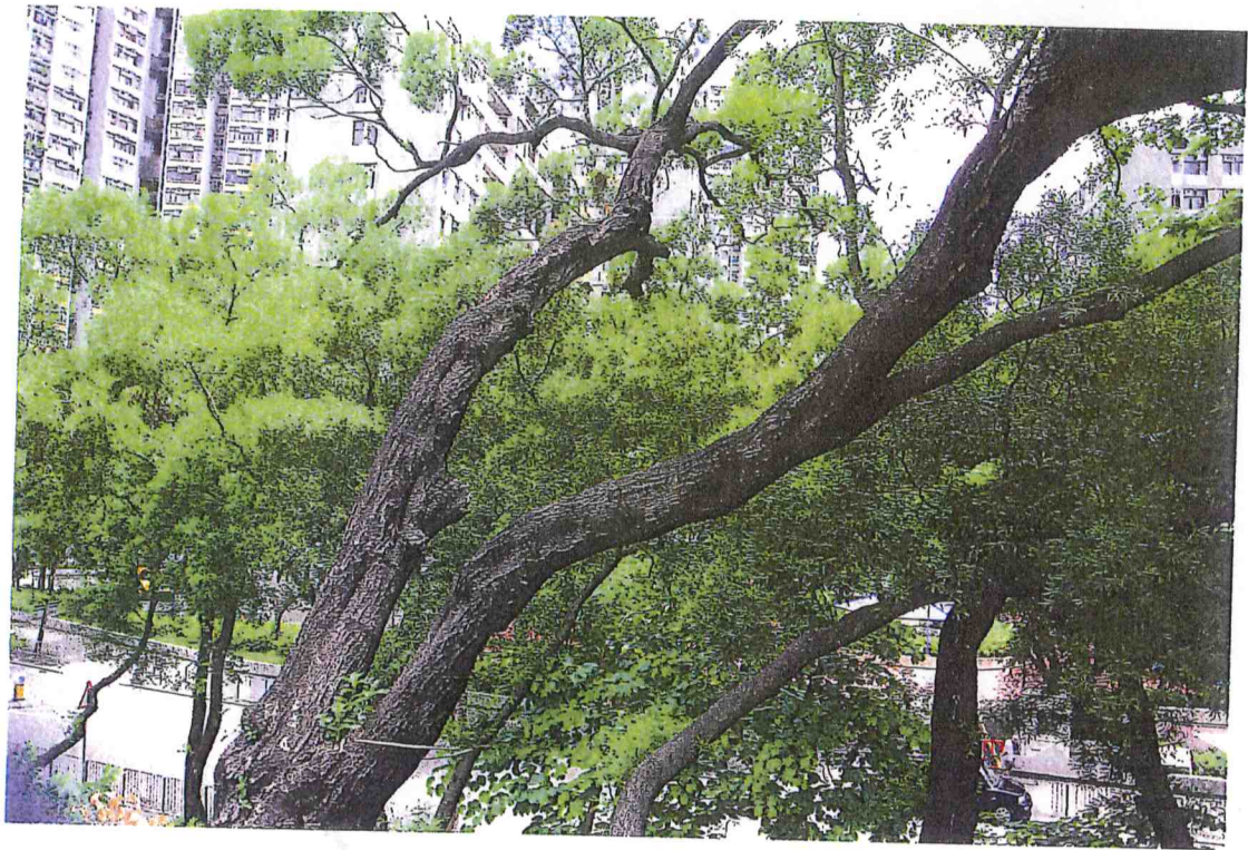
偉東樓對面 摩士公園斜坡 (已被蟲蛀)
