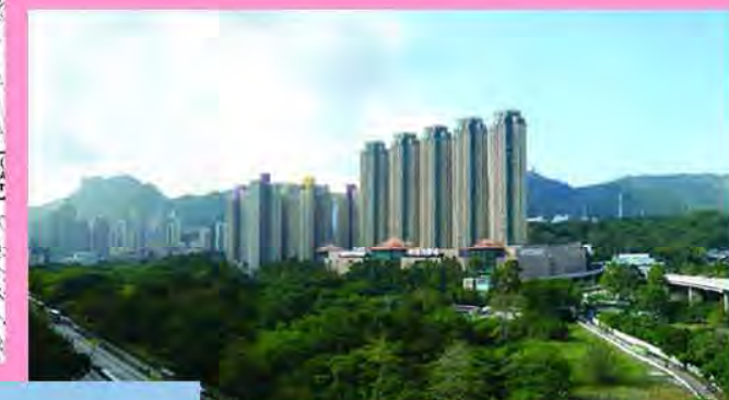
現時景況 EXISTING VIEW
