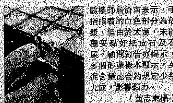
驗樓師詹濟南表示，手指指著的白色部分為砂漿，但由於太薄，未能黏好紙皮石及石屎。顧問報告亦顯示，多個砂漿樣本顯示，英泥含量比合約規定少約九成，影響黏力。（黃志東攝）
