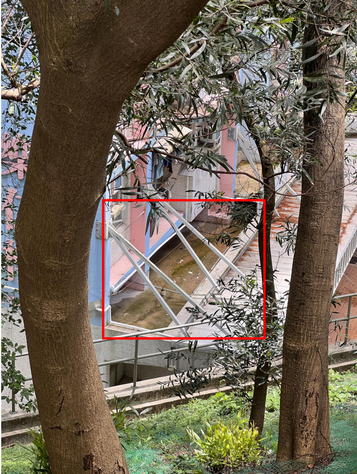
附圖七：樂仁樓平台簷篷出現大片冷氣機造成積水
