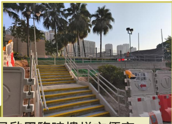
已啟用臨時樓梯方便市民在施工期間進出公園
