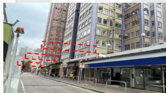
(飛鳳街) 清拆後
