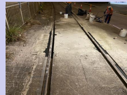
回填混凝土坑
