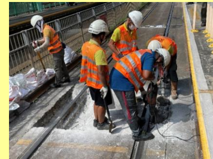
破碎混凝土坑
