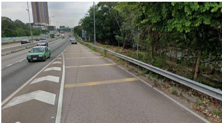
元朗三號幹線橫跨博愛醫院迴旋處往十八鄉迴旋處入路口的位置(圖 5) 路面已劃上提示減速的黃線
