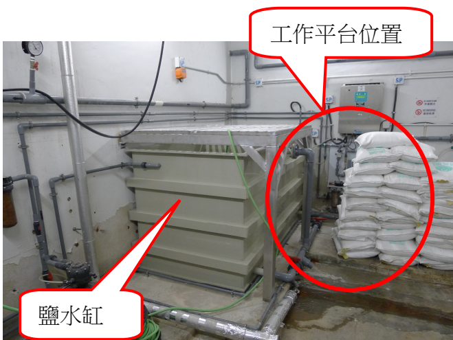
d. 在鹽缸上裝置工作平台，使員工倒鹽入鹽水缸時更安全。
