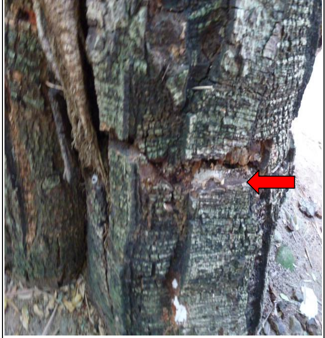
(出現裂縫，並出現傾斜現象)
