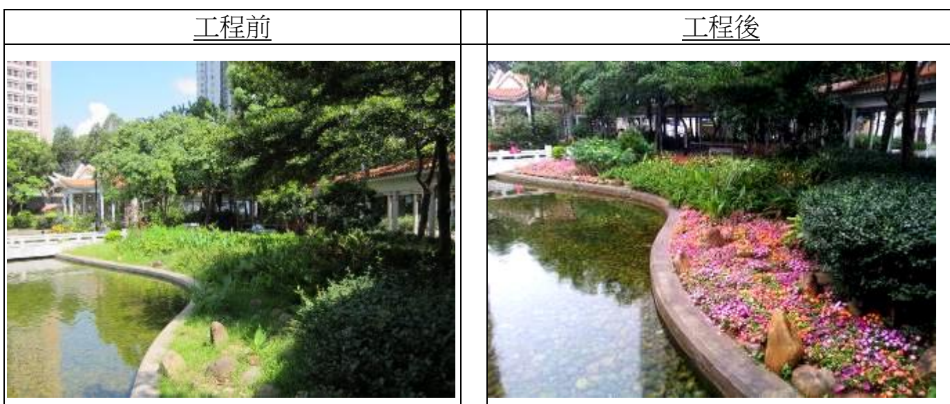
在樂群街公園進行綠化及美化工程 (約 500 平方米)
