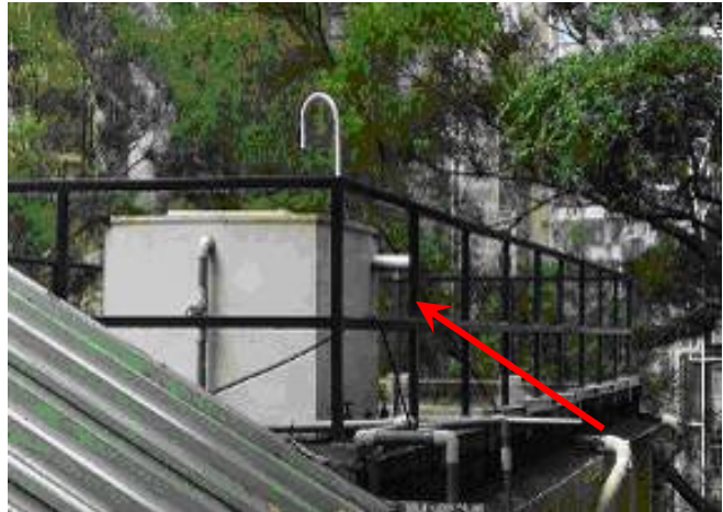
天台加設圍欄
