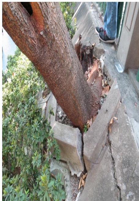
(樹身嚴重傾斜，根基移位)
