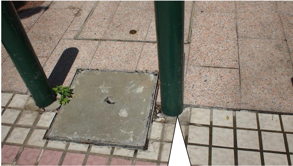
修補破損的地磚及更換伸縮縫物料
