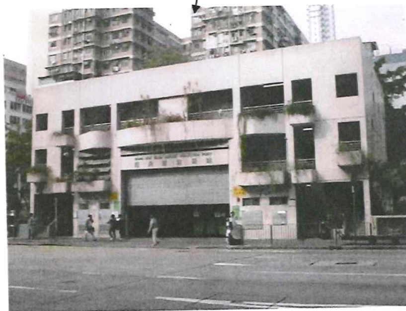
旺角道垃圾收集站及公廁 (男、女廁位於二樓，無障礙廁所位於地下)
