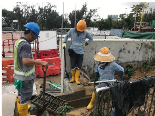
清理工地及排水系統
