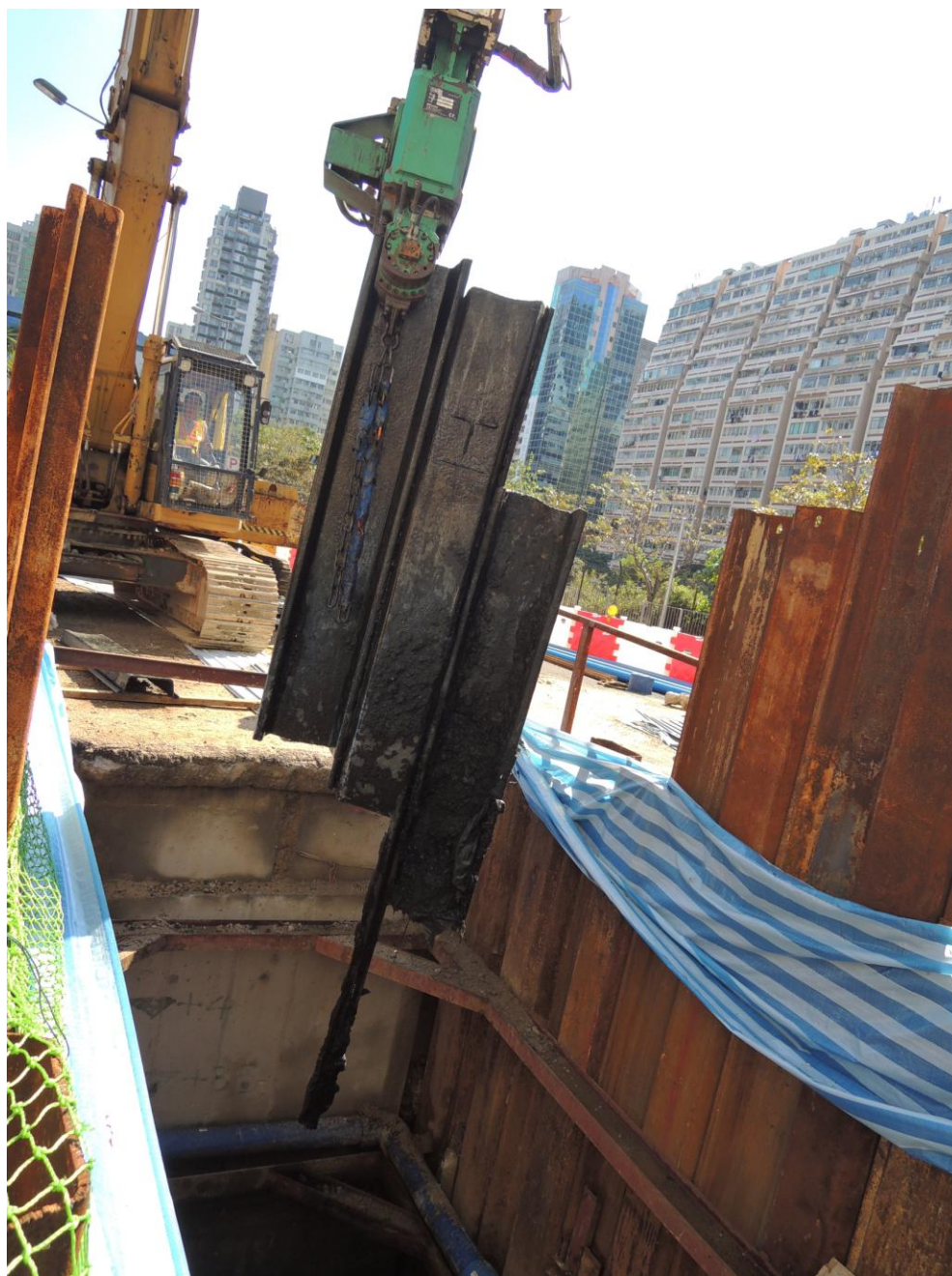
於渠道內吊出的閘板
