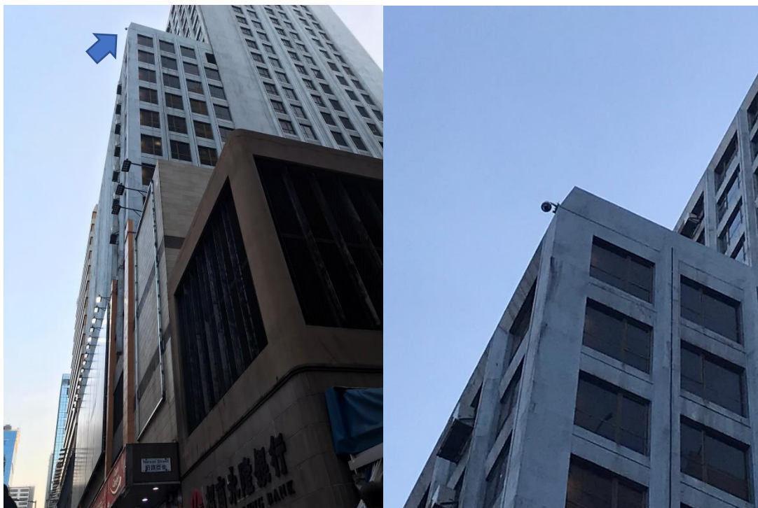
旺角招商永隆銀行中心外之閉路電視
